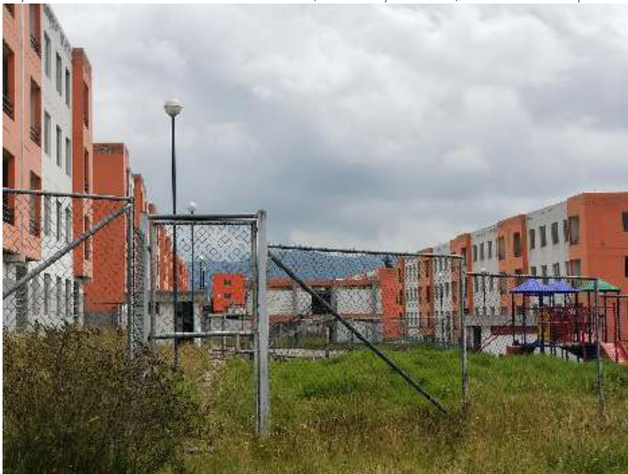
Proyecto Vivienda de Interés Social Victoria del Sur en DMQ (abandonado y deshabitado), 2019. Foto: Paulina Cepeda
