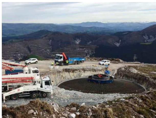
Mostras do impacto das obras.
