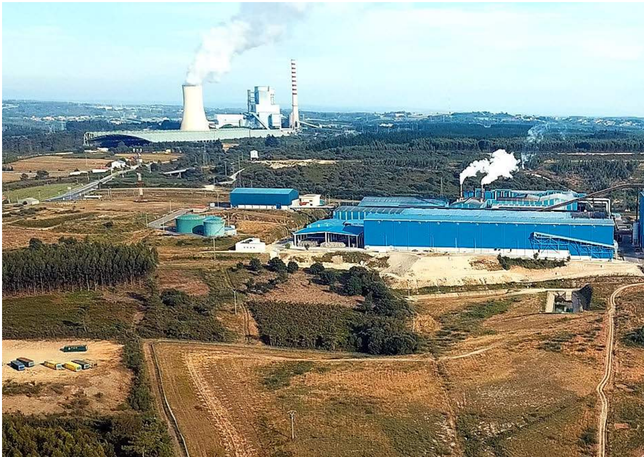
Instalaciones de SOGAMA con la central térmica al fondo. En la posición intermedia la escombrera forestada con eucaliptos. Desde la escombrera se implantará una serie de parques eólicos hasta el horizonte, con más de 150 generadores de 200 metros de altura en la punta de las palas. Fotografía facilitada por Salvemos a Comarca de Ordes .
