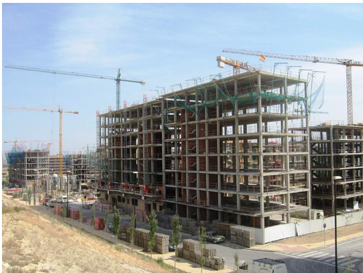
Estructuras en construcción. Foto: Niplos. Dominio público, httpscommons.wikimedia.org/windex.php?curid=4761995
