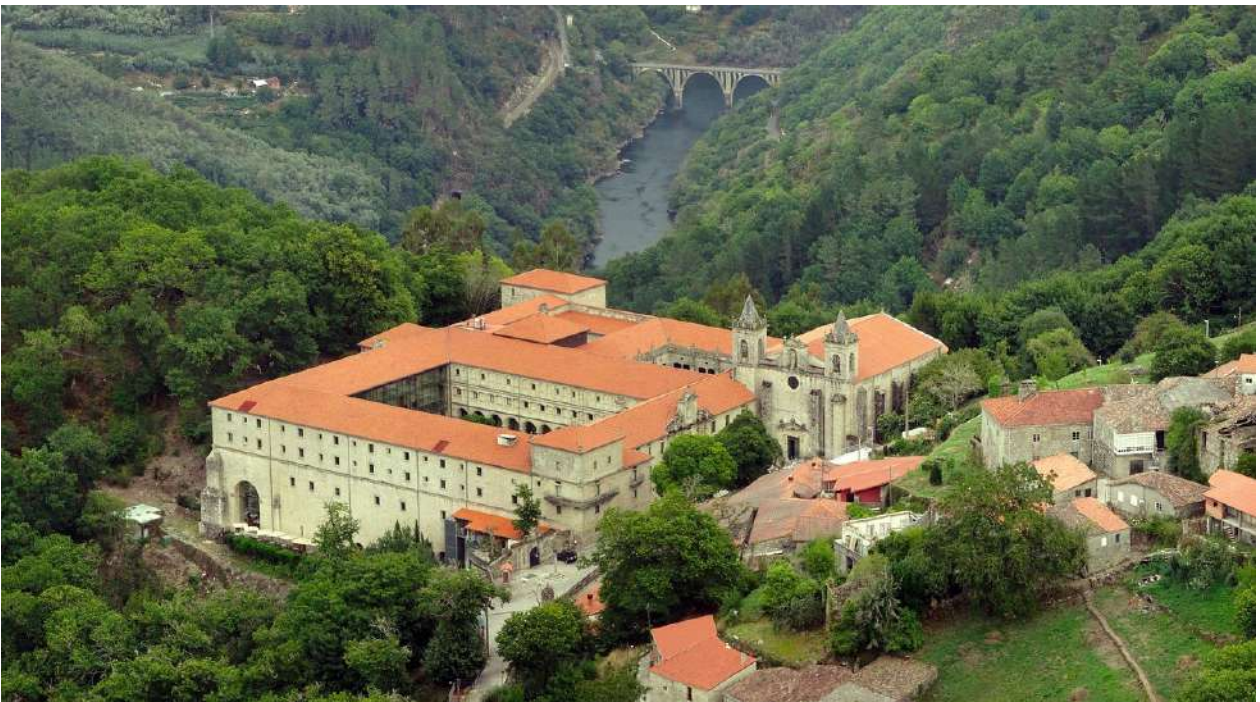
Monasterio de San Estevo de Ribas de Sil en la Ribeira Sacra, rehabilitado como hotel de lujo.
