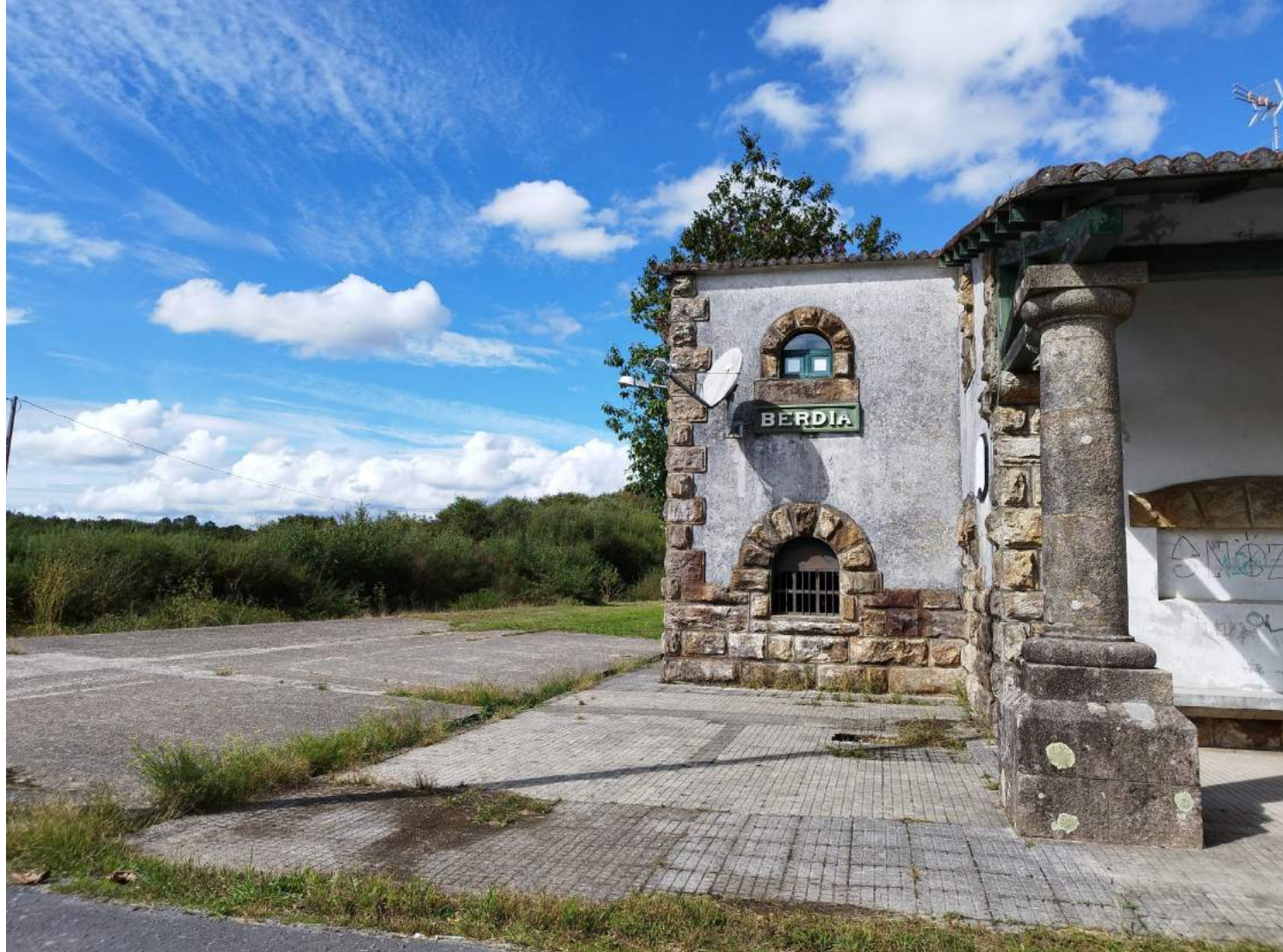
Antigua estación ferroviaria de Berdía (Santiago de Compostela), hoy clausurada y sin servicio. Foto: Miguel Pazos, 25 de septiembre de 2023.
