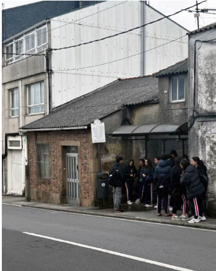
Parada de autobús en el barrio de Eirís (A Coruña) cuyo mal diseño supone una barrera para la movilidad peatonal. Foto: Sara Vázquez.
